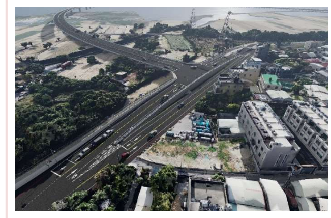
臺中大肚-彰化和美 跨河橋樑新建工程 預計2026年底完工
