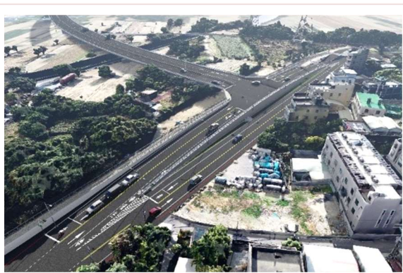
臺中大肚-彰化和美 跨河橋樑新建工程 預計115年底完工
