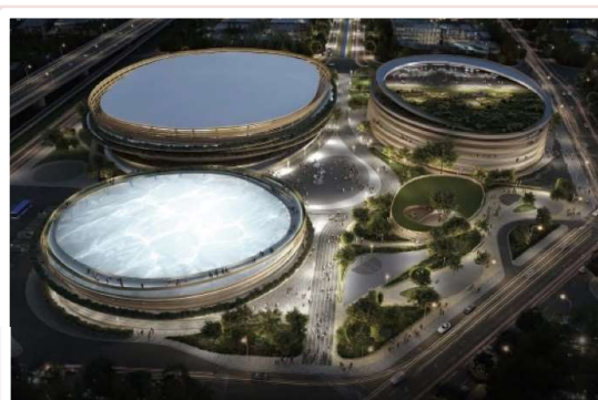
台中大巨蛋 119年10月完工
