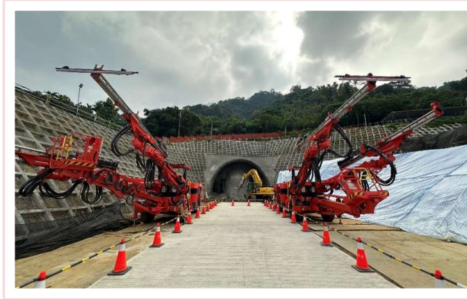
東勢-豐原生活圈快速道路 預計115年東勢至石岡段通車 全線118年完工
