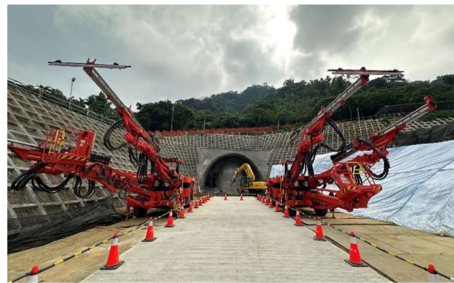
東勢-豐原生活圈快速道路 預計115年底東勢至石岡段通車 全線目標118年完工
