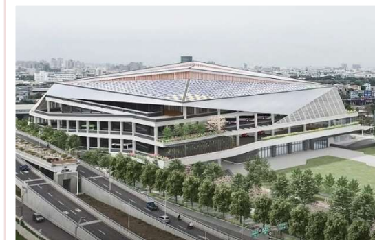
水湳轉運中心(115/8/5啟用) 大臺中轉運中心(預計115年下半年啟用)
